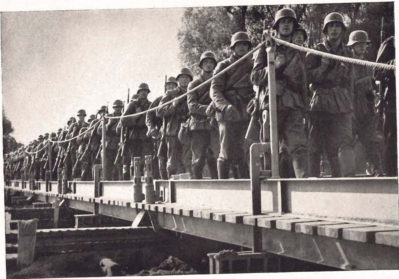
Der Brückenbau unserer Pioniere ist allen Anforderungen gewachsen
