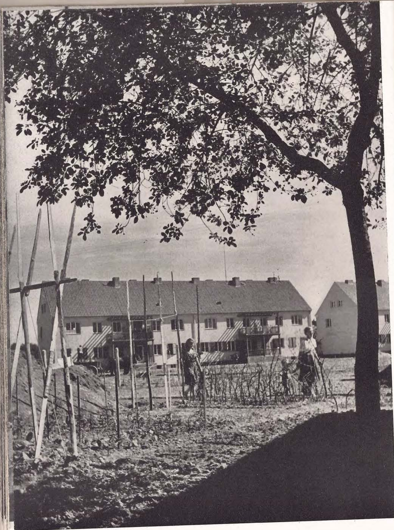
82 Zu jedem Haus gehört ein Stück Garten. Noch ist der Boden kahl, aber bald wird auch diese Erde Früchte tragen.
